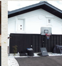
外部改修仕上げ
