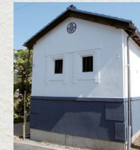
外部改修仕上げ
